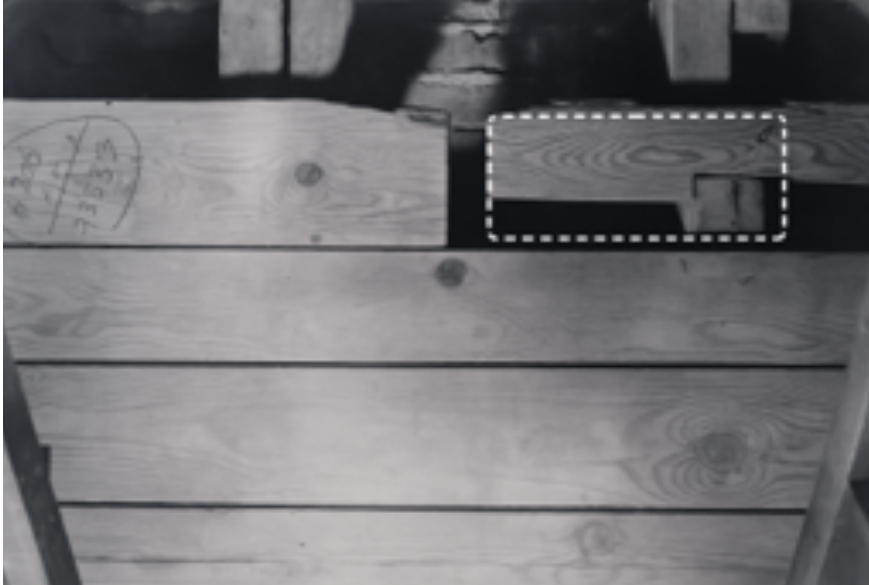
Görsel 12. Bronx'taki Hauptmann tavan arası – Tavan arasının zeminine yerleştirilmiş 16 numaralı merdiven korkuluğunun yakından görünümü. Görsel, New Jersey Eyalet Arşivleri'nden izin alınarak kullanılmıştır.
